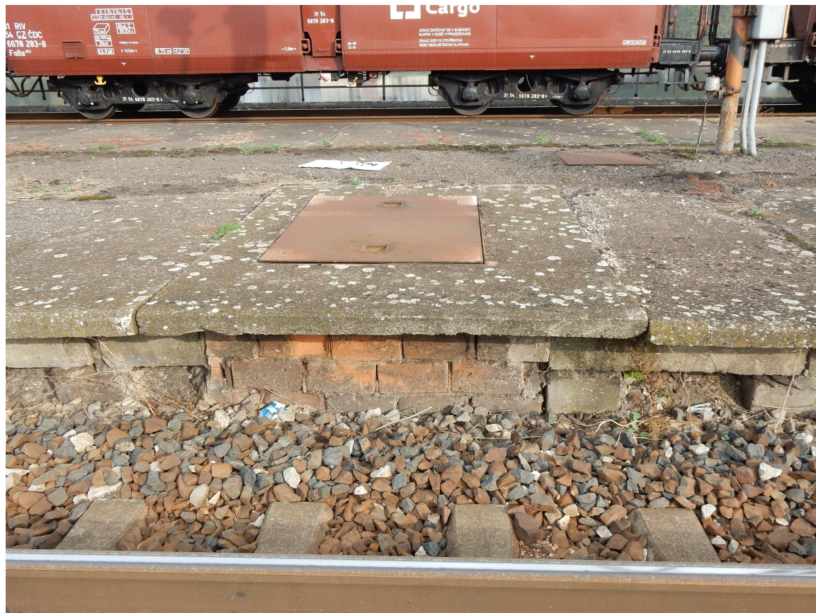
Fotografie 15-2: Stávající nástupiště s šachtou kabelovodu
