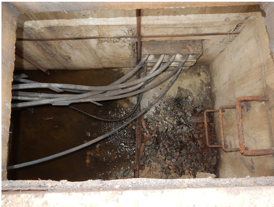
Fotografie 15-3: Vstup prefabrikátů do šachty
